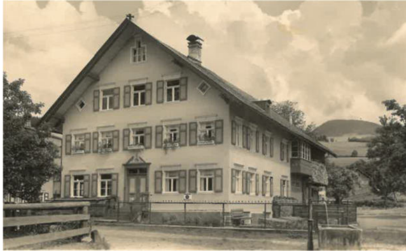
Ursprünglicher Zustand Hinanger Straße 3
