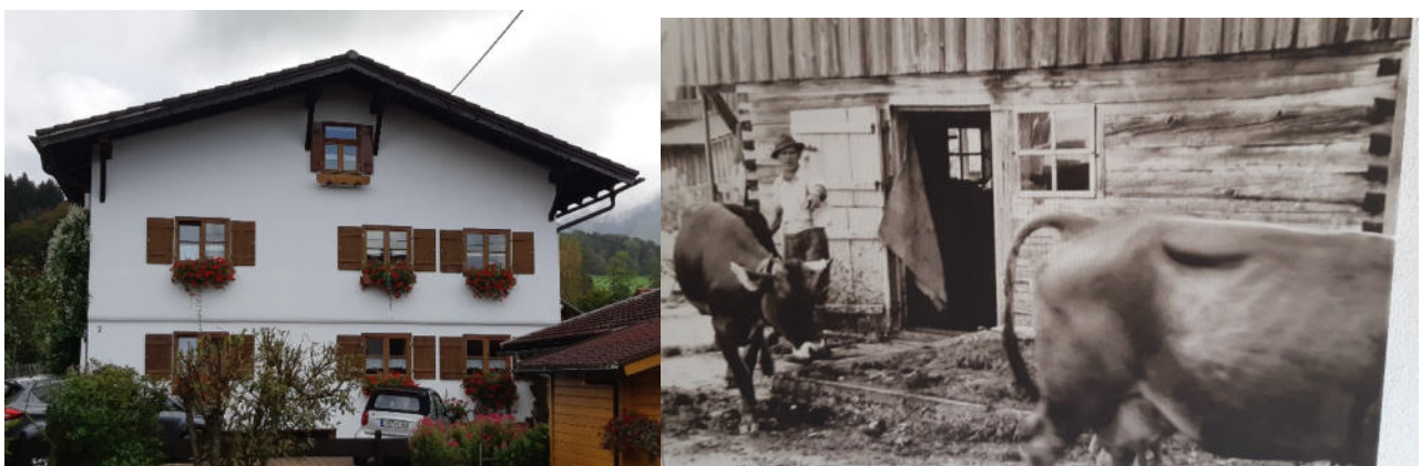
Bergstraße 2 mit historischem Foto vom in den Einfirsthof integrierten Stall in gestrickter Bauweise
