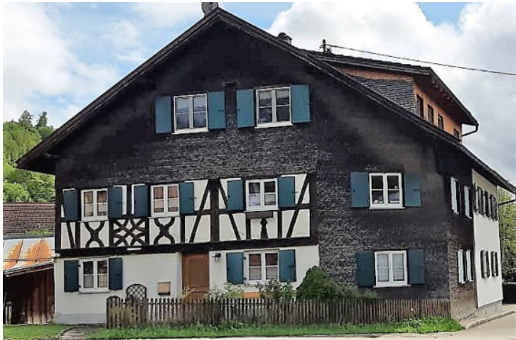
Gebäude Am Naglerweg 14
