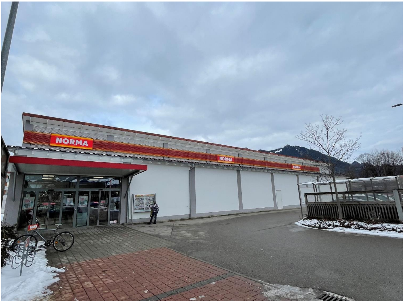
Abbildung 3 Norma in der Östlichen Alpenstraße
